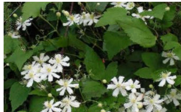
Bestaande keermuur met klimplanten ■ ■
