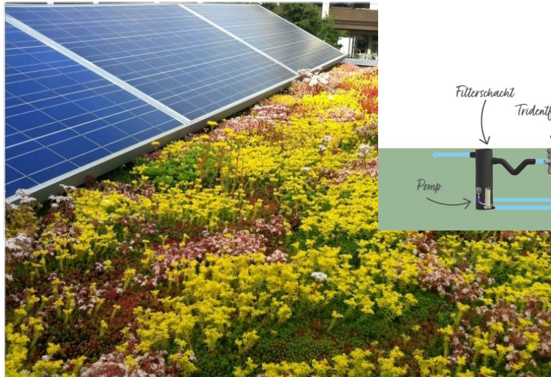
Groen dak met zonnepanelen
