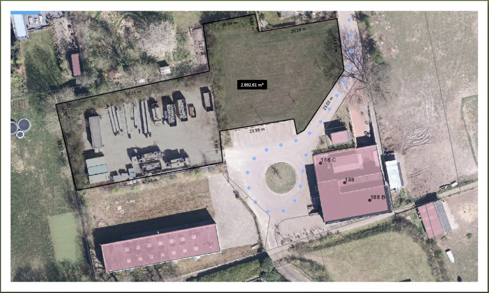
Terrein voormalige gasfabriek: grasveld en gemeentewerf
