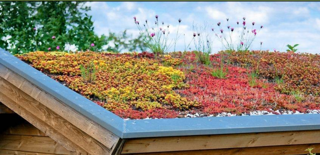
Groen dak voor regenwaterbeheer, verkoeling en afvang van fijnstof
