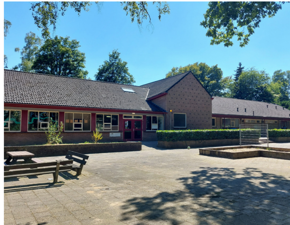
Overzicht schoolgebouw vanaf noordzijde
