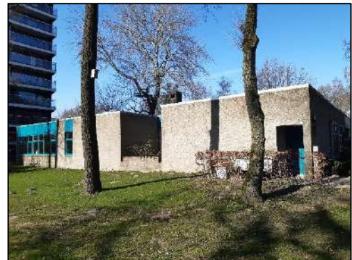
De bebouwing gezien vanuit het zuiden.
