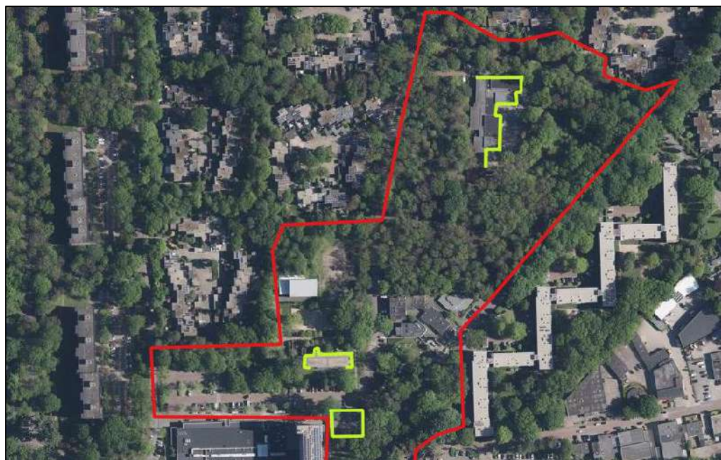
Mogelijkheden voor gebouwbewonende vleermuizen. Voor de bebouwing die mogelijk wordt gesloopt, zijn met geel de gevels aangegeven waar openingen aanwezig zijn die door vleermuizen als toegang tot een verblijfplaats zouden kunnen worden gebruikt.
