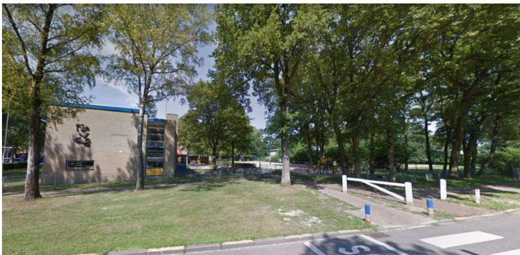
Figuur 7: Foto van locatie B, genomen vanaf de Bachlaan in westelijke richting (Google Maps Street View juli 2017).
