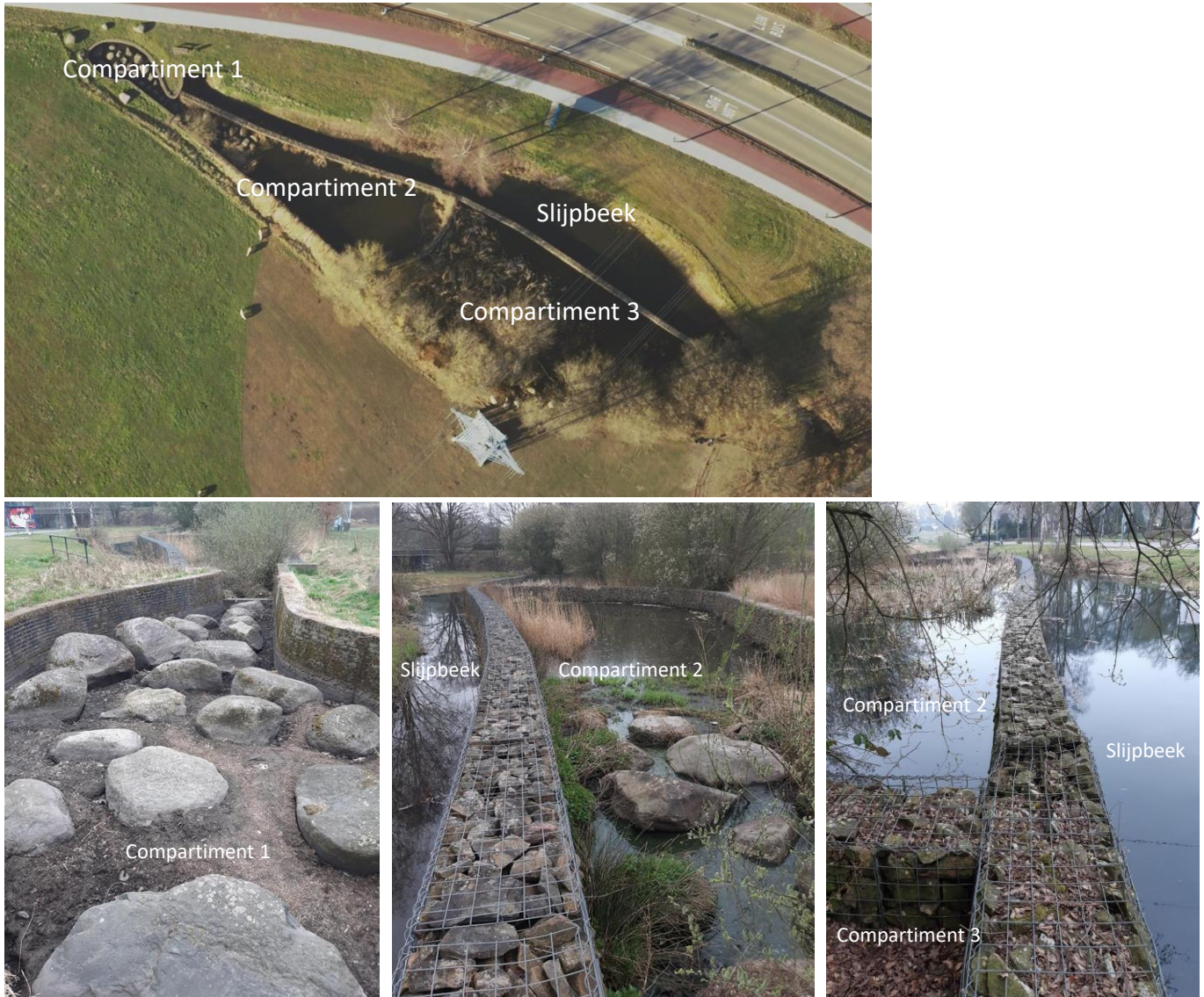
Figuur 6: Overzicht en inrichting bestaand werk met schanskorven t.b.v. opvang hemelwater afkomstig van Utrechtseweg
