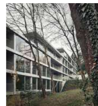
Vorm en de plaatsing van de openingen volgen oorspronkelijke architectuur.
