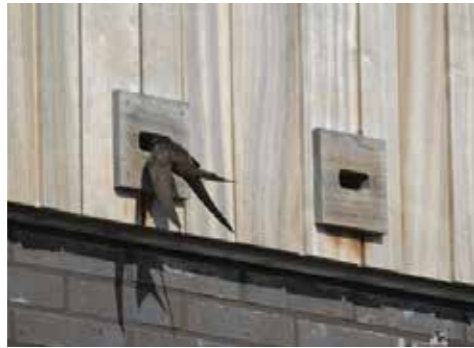
Nestkasten als zichtbaar architectonisch ornament.
