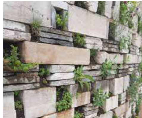
Het poreus maken van de gevel ter bevordering van de biodiversiteit is onderdeel van het gevelontwerp en geïntegreerd met de architectonische uitwerkingen.
