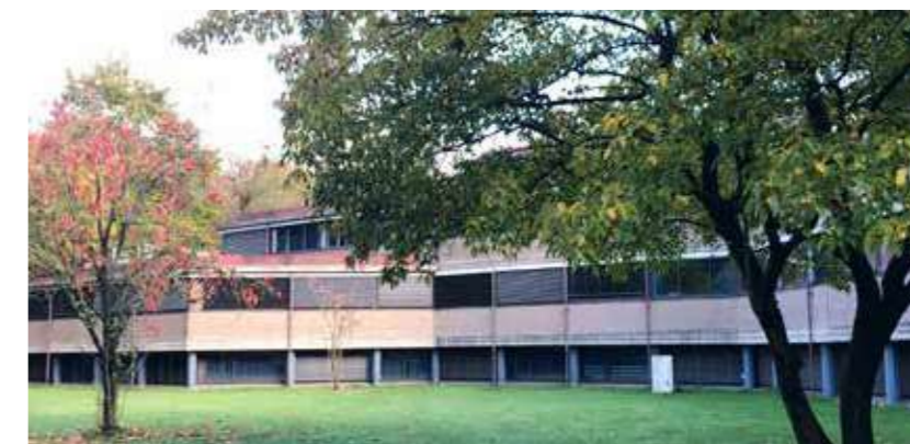
Het oorspronkelijke gebouw H01/H02 kenmerkt zich door een sterke horizontale architectuur van de gevel met dikke dakranden en een eenduidig stramen van gevelopeningen. Deze architectuur dient als basis voor de transformatie.
