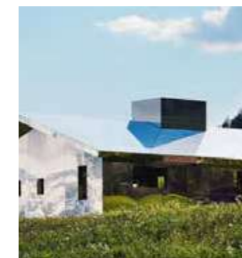
Glas met vogelvriendelijk coating om reflectie te verstoren
