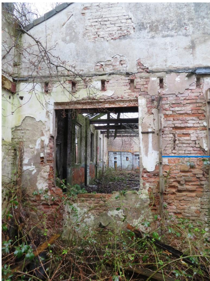
Afbeelding 12 Afwijkend metselwerk ruimte A3 (blauwe lijn, foto richting het oosten).
