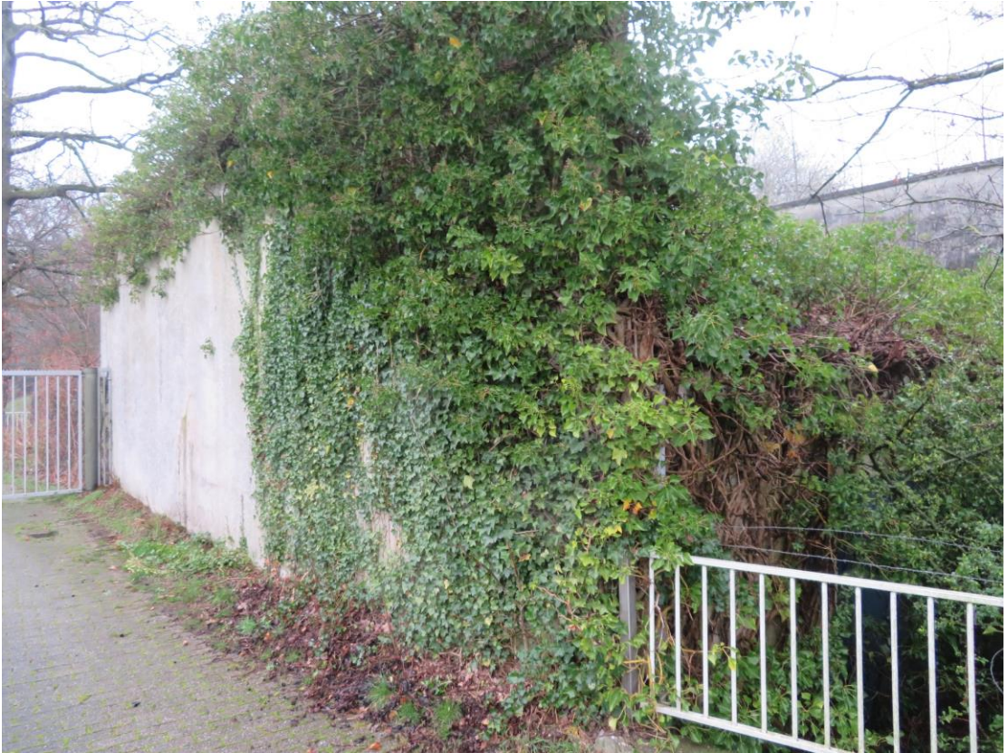
De westgevel van A5.
