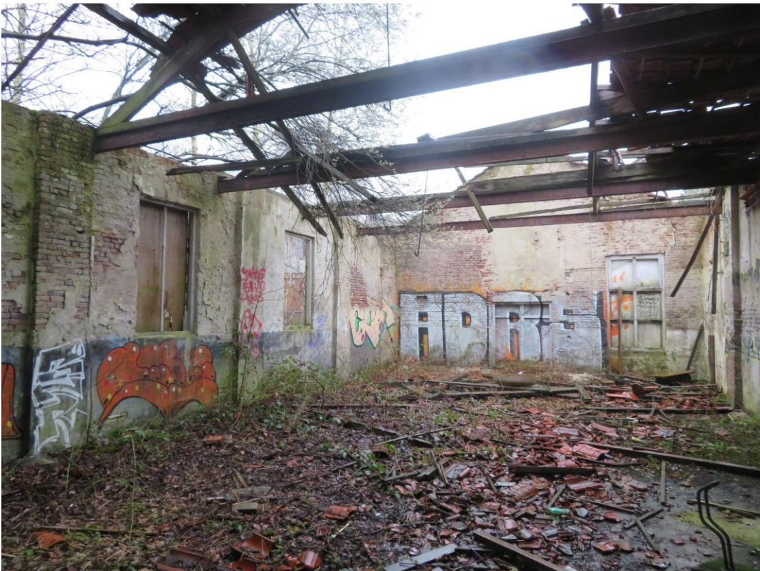
A1 – gezien in noordoostelijke richting.
