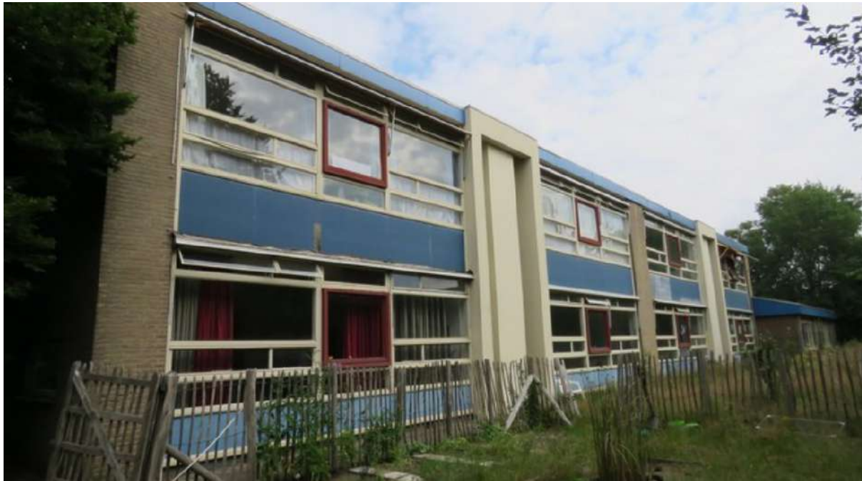
Huidige situatie van één van de schoolgebouwen in het plangebied gezien (bron: Breurs).
