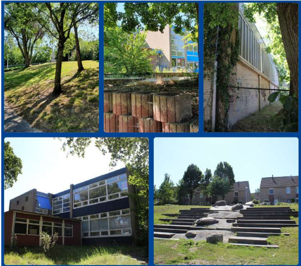
Foto's planlocatie aan de Bram Streeflandweg (groen en hoogteverschil, schoolgebouwen en gymzaal en de 'kuil'). (bron: 'Stedenbouwkundige kaders Scholenstrip Bram Streeflandweg'; LOS stadomland B.V.)
