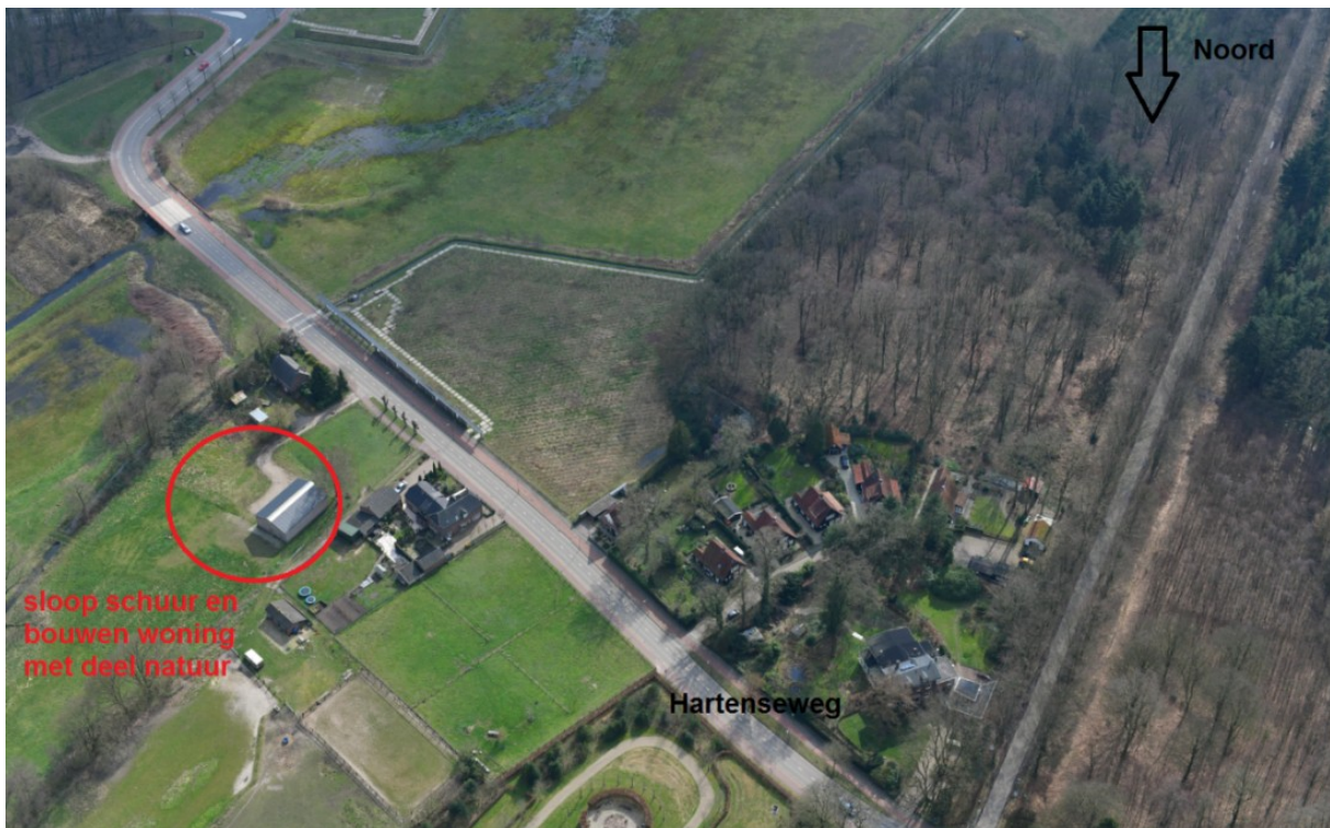
Afbeelding: luchtfoto plangebied (voorjaar 2019) (Bron: GeoOblik, Slagboom en Peeters), (kijkrichting naar het zuiden)
