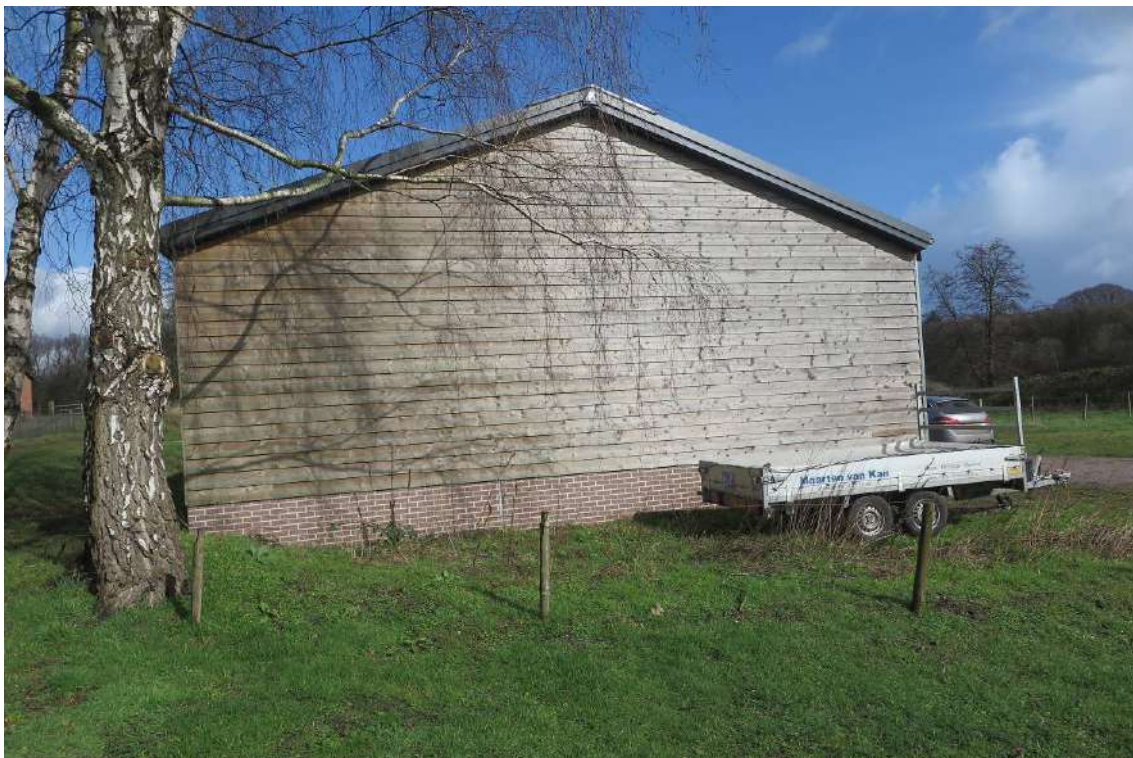
Vervolg figuur 2. Foto-impressie van de te slopen schuur aan de Hartenseweg 7 te Renkum.
