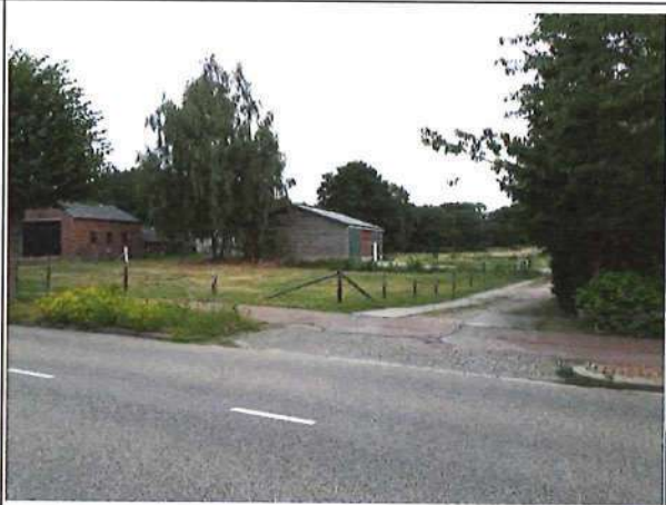
Afbeelding: Bestaande schuur, kijkrichting naar het noorden, rechts oprit Hartenseweg 5 en 7 en links Hartenseweg 9 (zomer 2020)
