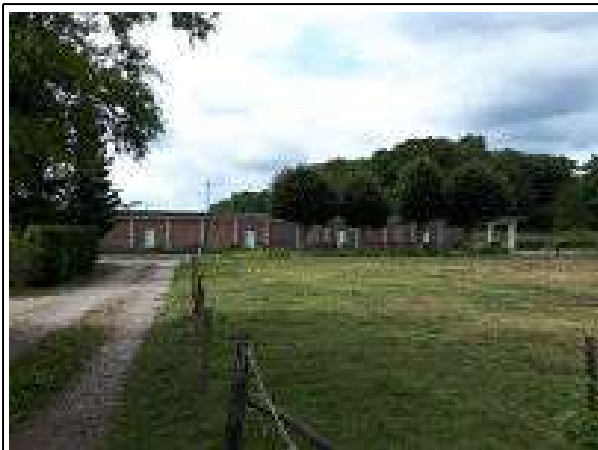
Afbeelding 2.13: oprit perceel, kijkend naar muur en lindes aan de Hartenseweg, kijkrichting naar het zuiden. Links de opgang naar de woning en tuin van Hartenseweg 5. Weiland op voorgrond hoort niet bij bestemmingsplan wijziging (zomer 2020)
