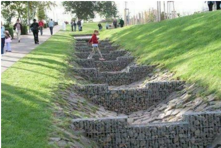
Ivm verloop schanskorven aanbrengen in wadi
