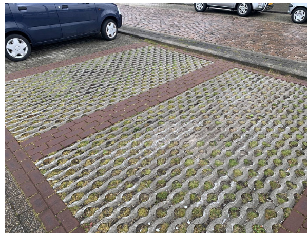
ïR, huidige situatie, betonklinkers
