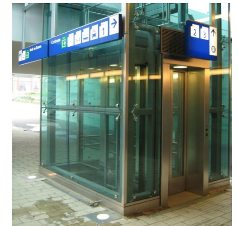
Deuren lift terugliggend uitgevoerd
