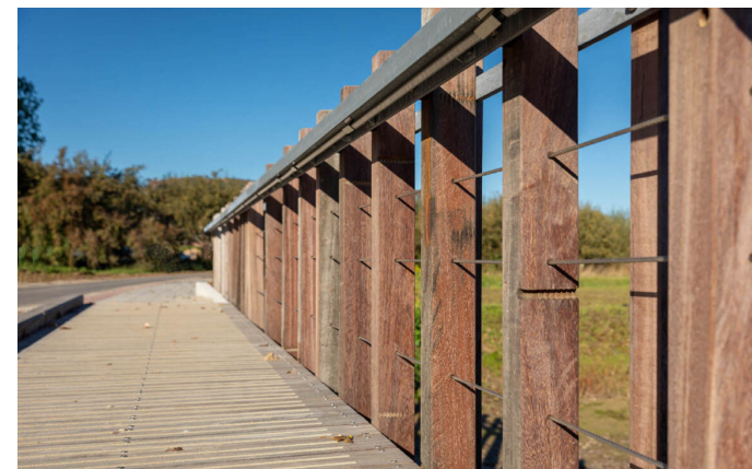
Voorbeeld brug met hergebruikt hardhout (brug Waalsprong)
