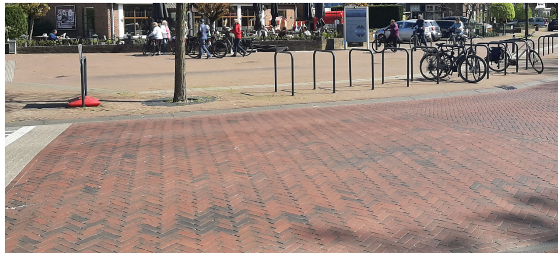
Huidige klinkers (Ravenna, Wienerberger) op de rijweg langs het plein
