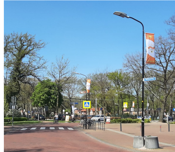
Lantarenpaal Schreder Teceo wordt ook toegepast langs rijbaan tunnel en fietspad
