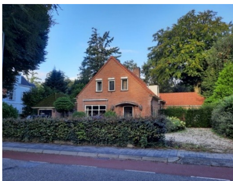
Afbeelding: foto bestaande pand aan de Stationsweg 4
