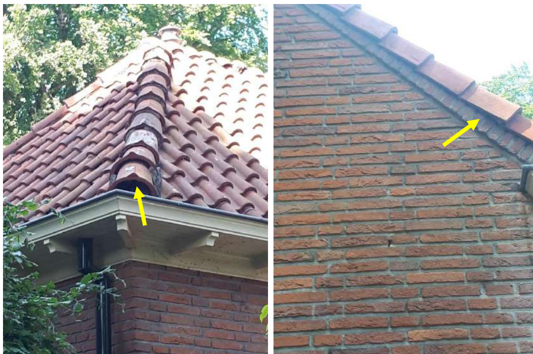
Figuur 6. Ruimtes onder nokvorst (links) en kantpannen (rechts) van het woonhuis
