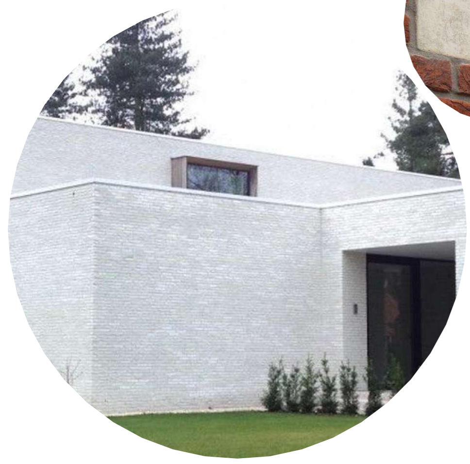
gevelmetselwerk door-en-door "witte" keramische steen
