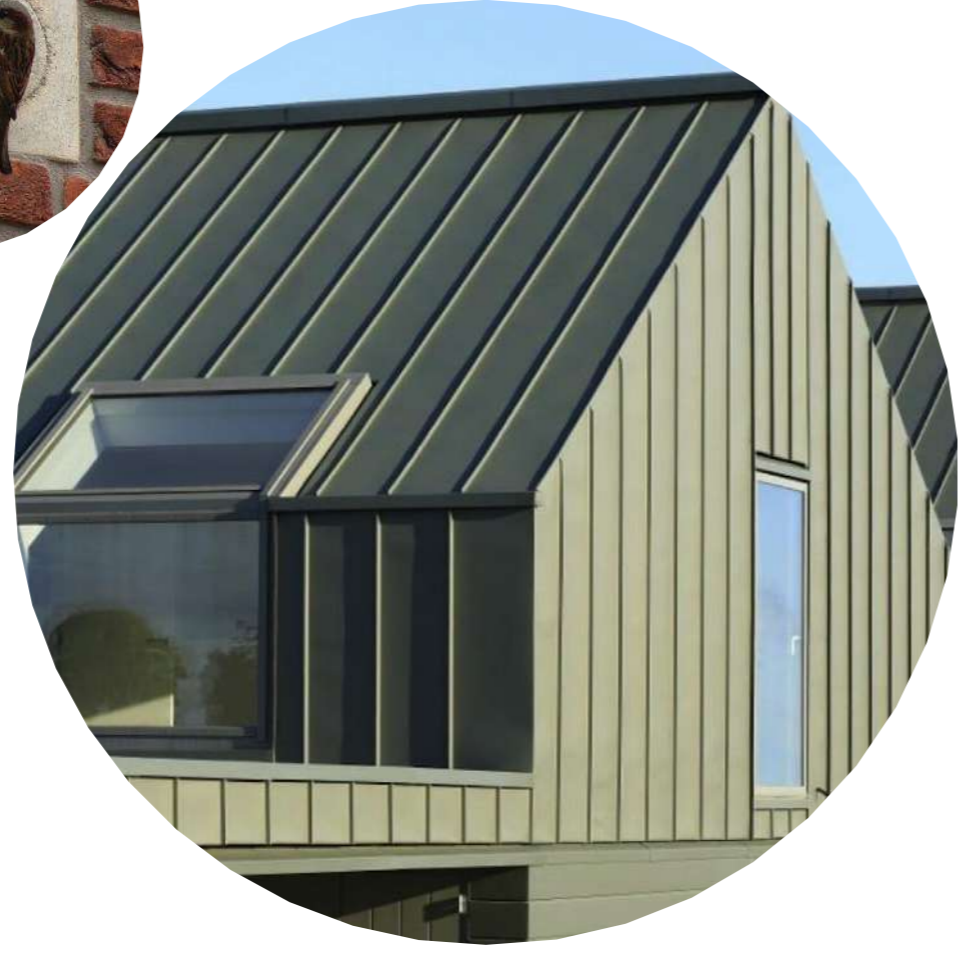
daken groen metalen felsdak
