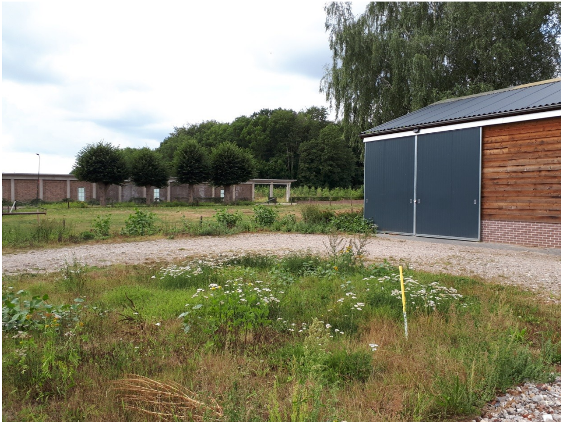
Afbeelding: Foto van de planlocatie met rechts de nieuwe schuur en op de achtergrond de Hartenseweg met de historische muur aan de andere zijde van de weg. In de huidige situatie ligt er meer (puin-)verharding dan op de luchtfoto's zichtbaar is. Het weiland voorbij de erfafscheiding met palen hoort niet bij de bestemmingsplanwijziging.
