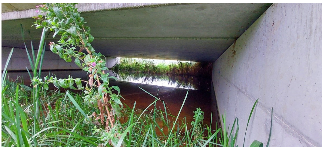
Figuur 3.2 Faunapassage onder de Hartenseweg, een rechthoekige tunnel van 11 meter breed en 1,5 meter hoog. Aan weerszijden van deze rechthoekige tunnel zijn twee ronde duikers aanwezig (figuur 3.3). Tijdens het veldbezoek stond in alle tunnels een laag water. Foto: Ecogroen.
