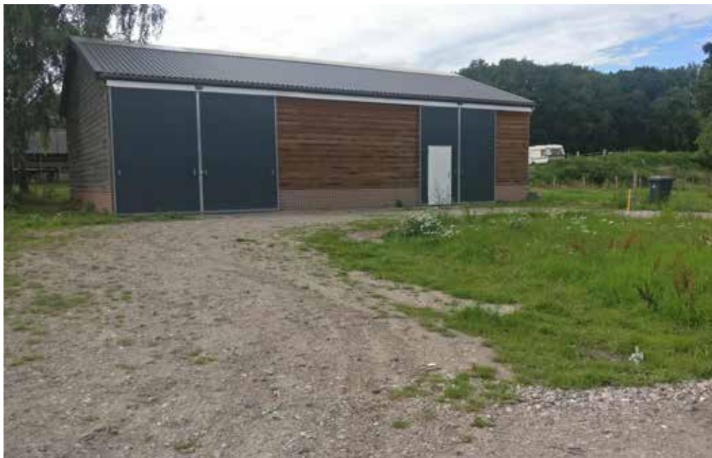
Schuur met puinverharding vanuit het westen gezien.
