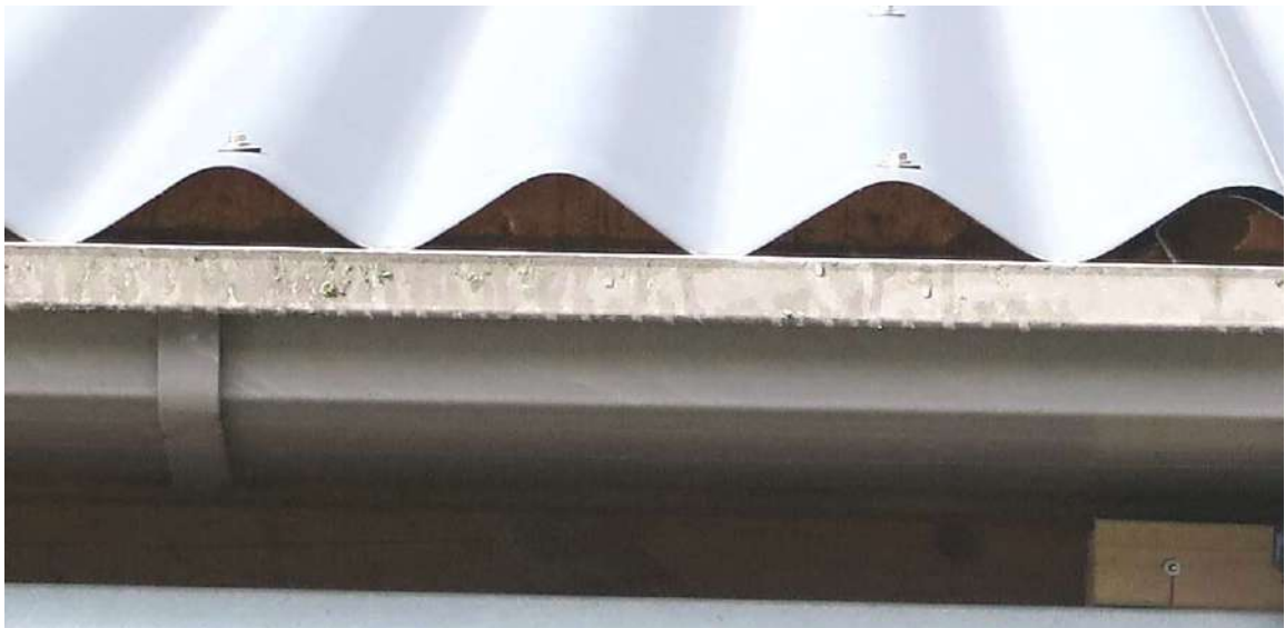
Figuur 3. Onderzijde dak van de te slopen schuur aan de Hartenseweg 7 te Renkum.
