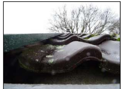
Figuur 16. Betimmering en dakgoot bij de onderste rij dakpannen.
