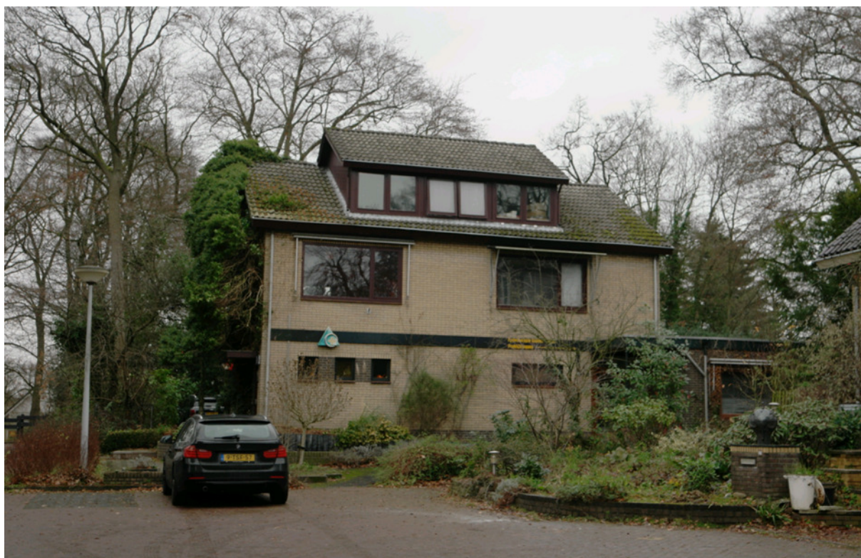
Afbeelding 2: bestaande situatie Ketsheuvel 34
