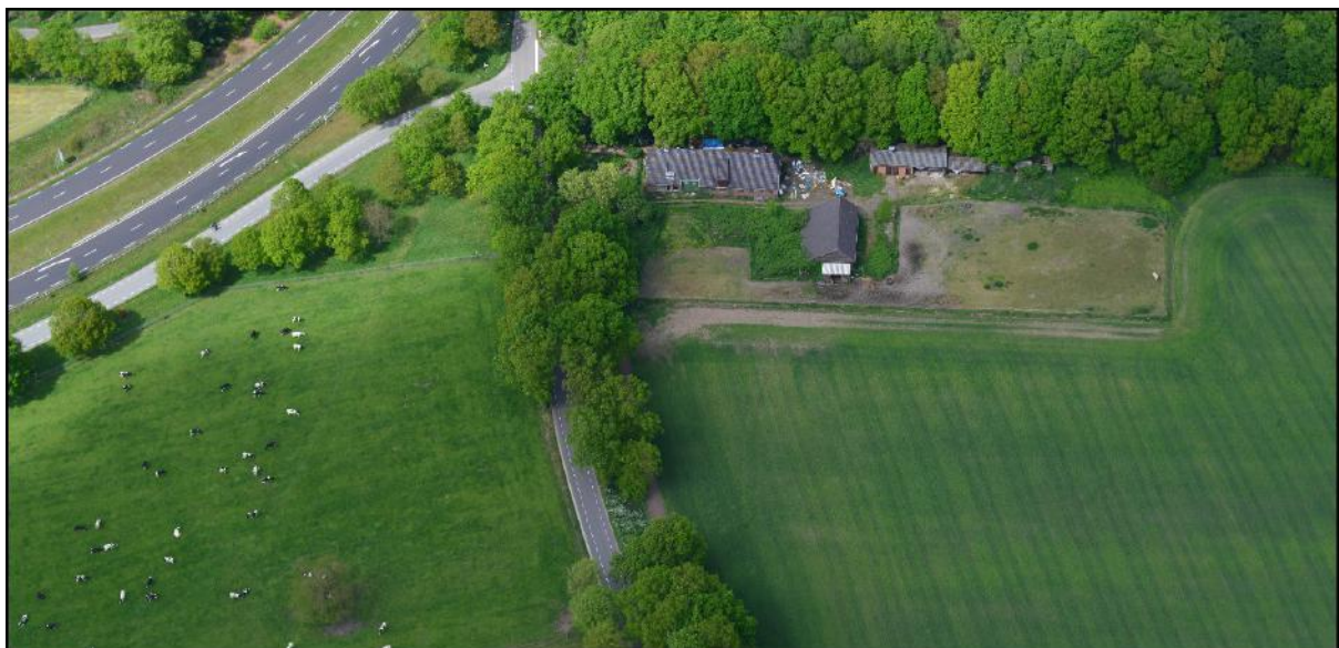
luchtfoto bestaande situatie Boersberg 2. (bron: Geo-obliek, Slagboom en Peeters)
