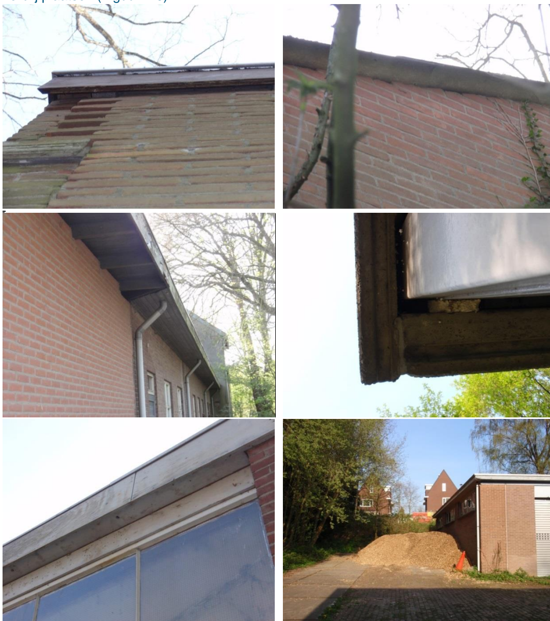
Figuur 4-5 Mogelijke verblijfplaatsen in de gebouwen in het plangebied. Foto's: RHDHV, 2018.
