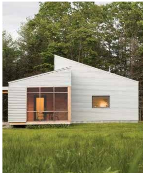
De dakvorm versterkt de bebouwing als monoliet volume.
