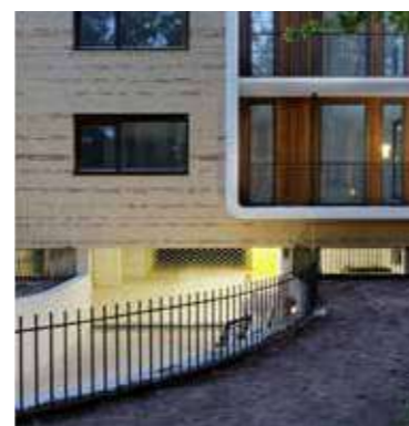
Geïntegreerde oplossingen voor inrit, balustrades en natuurlijke ventilatie openingen
