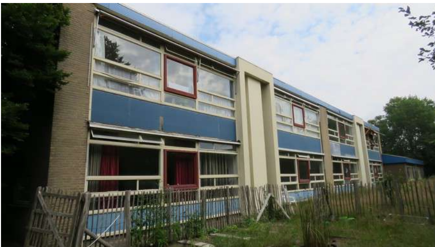
Afbeelding 26: Zicht op klaslokaalzijde van gebouw B. Grote delen bestaan uit glas en gevelpanelen, in het centrale deel met baksteen zijn geen stootvoegen aanwezig.
