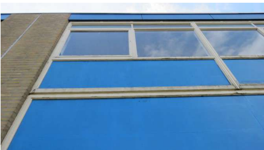
Afbeelding 27: Gebouw B. Dilatatievoeg met intacte kitrand, kozijnen sluiten aan op geveldelen, grote delen met glas en gladde gevelpanelen.
