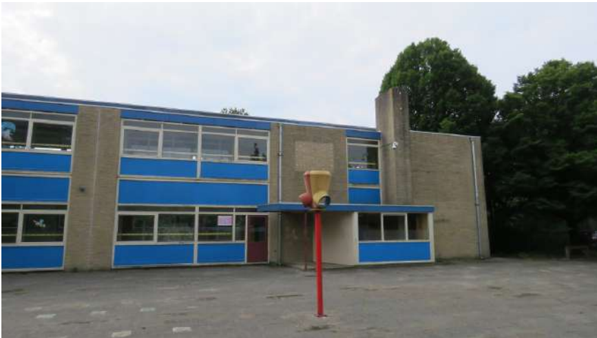
Afbeelding 2: Het middelste schoolgebouw in het plangebied.
