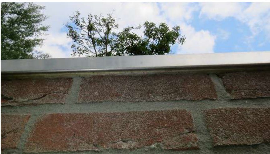
Afbeelding 33: Onder de dakrim van een bijgebouwtje is geen ruimte. Tevens is er geen spouwmuur aanwezig. Dit geldt voor alle bijgebouwen, kleine (halfopen) schuurtjes of fietsenstallingen waren volledig ongeschikt als vleermuisverblijfplaats.
