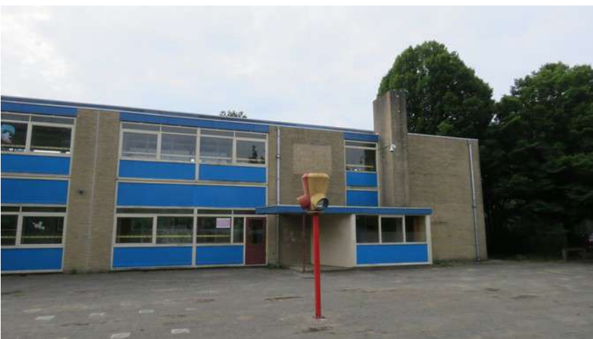
Afbeelding 24: Zicht vanaf het schoolplein op gebouw B. Grote delen bestaan uit glas en gevelpanelen, enkele geveldelen bestaan uit baksteen.
