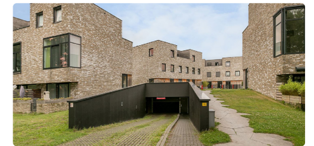
Afbeelding 24. Foto's van insnijdingen in een talud met behoud van het groene beeld.
