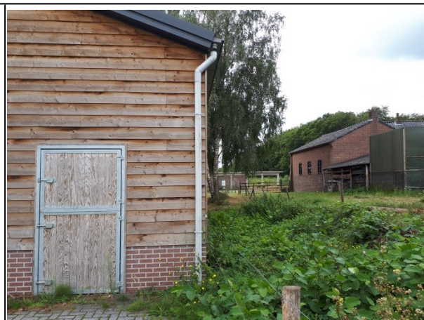
Afbeelding: bestaande schuur (zomer 2020), kijkrichting naar het zuiden, pad en rechts woonbebouwing bij Hartenseweg 9.
