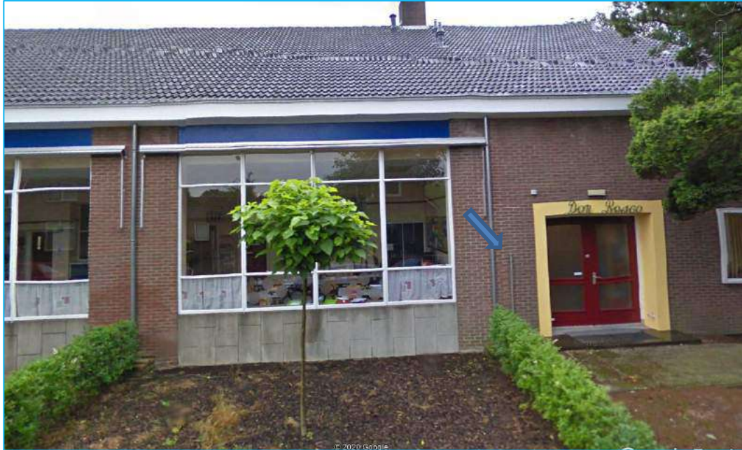
Figuur 1: locatie (vm)-ondergrondse HBO-tank met ontluuchtingspunt
