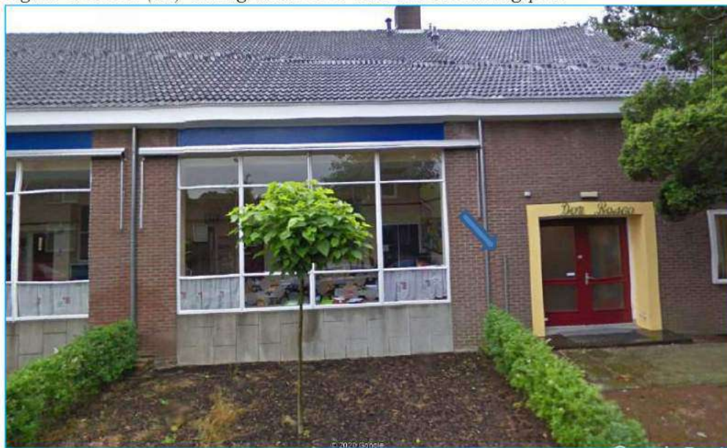
Figuur 1: locatie (vm)-ondergrondse HBO-tank met ontluuchtingspunt
