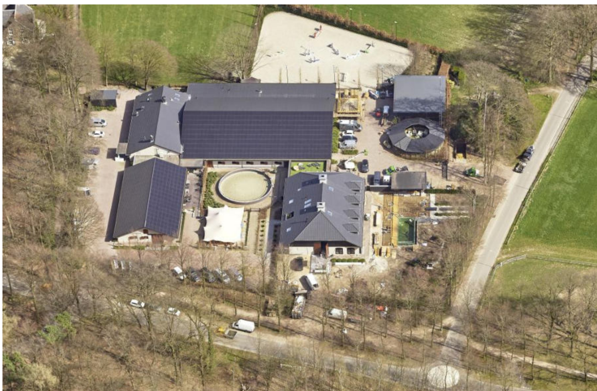
Afbeelding 2.5: luchtfoto voorjaar 2021, kijkrichting naar het oosten, Valkenburglaan 1 (bron:
