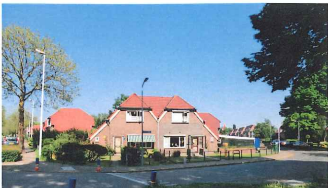
symmetrische gevel en dakvorm
