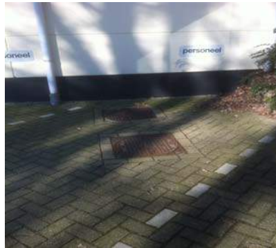
Foto: Slibvangput en OBAS werkplaats
