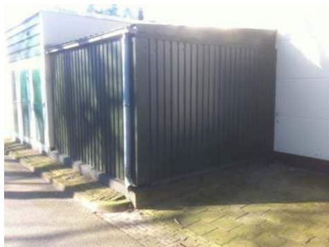
Foto: Olieopslag achter werkplaats
