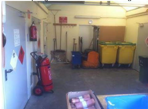
Foto's: KCA depot met vloestofdichte vloer
