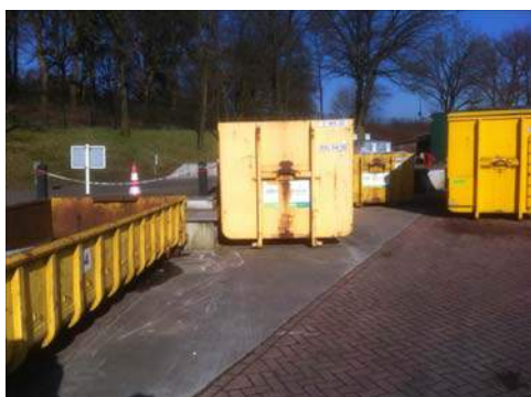
Foto: Containers op vloestofdichte vloer
