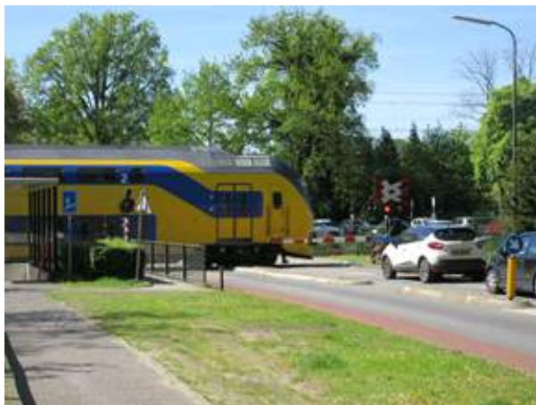
spoorwegovergang (richting het zuiden)
