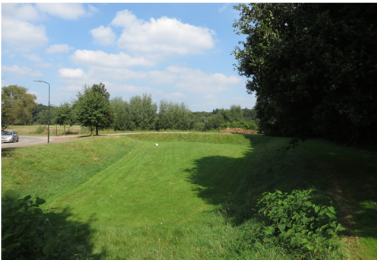
Een wadi aan de rand van het Renkums Beekdal. Hierin kan regenwater opgevangen worden en langzaam in de grond zakken.
