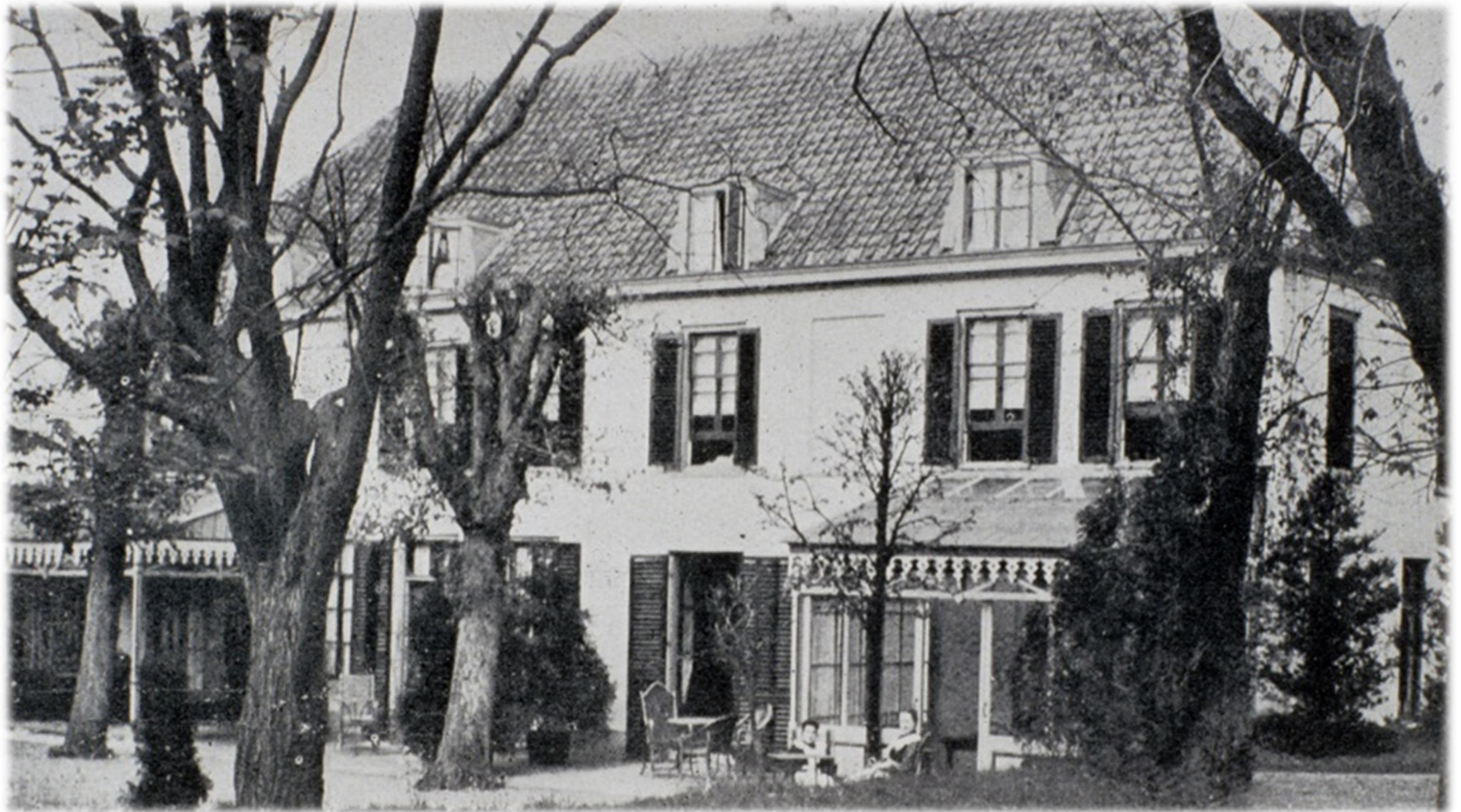
De achterzijde van Dreijeroord omstreeks 1890 (met louvere luiken zuidzijde)
