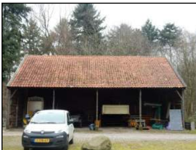
Figuur 6. Open kapschuur, noordzijde erf.
