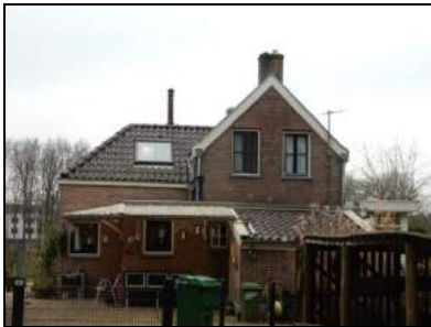
Figuur 3. Woonhuis op onderzoekslocatie.
