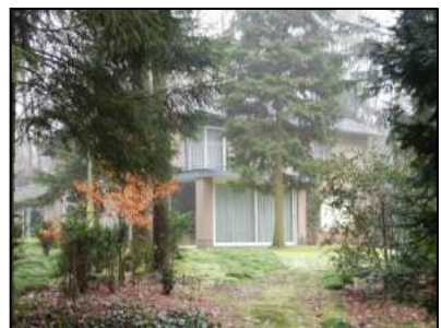
Figuur 8. Woonhuis aan de Baliweg 14.
