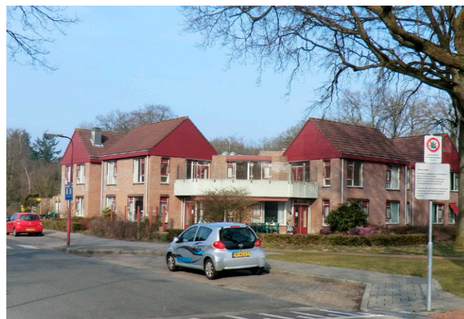
bestaande situatie Plein 7 t/m 10
