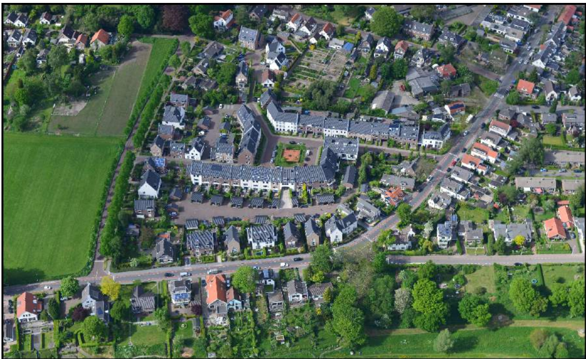
Kerkeland (naar het noorden bekeken), links de Van Toulon van der Koogweg, rechts de Jhr. Nedermeijer van Rosenthalweg en onderaan de Benedendorpsweg.
