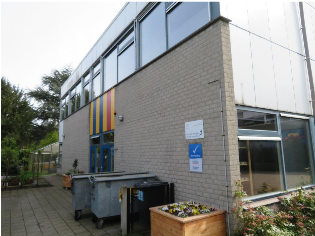
Afbeelding 1: Vooraanzicht schoolgebouw in het plangebied.
