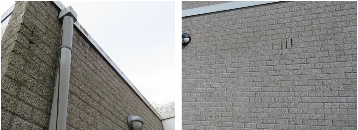
Afbeelding 30 en 31: Daklijst rondom de bebouwing en ventilatiespleten.
