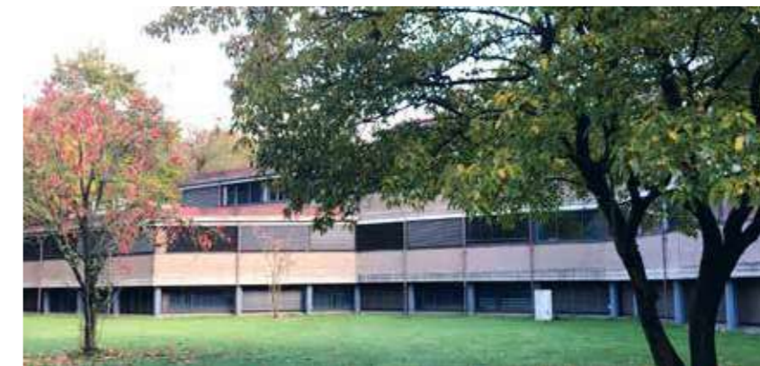
Het oorspronkelijke gebouw H01/H02 kenmerkt zich door een sterke horizontale architectuur van de gevel met dikke dakranden en een eenduidig stramen van gevelopeningen. Deze architectuur dient als basis voor de transformatie.
