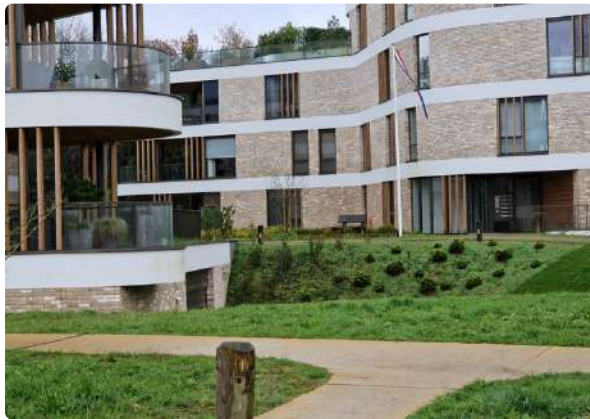
Afbeelding 25. Foto's van verdiepte parkeergebouwen, mee ontworpen met zowel het gebouw als de groene omgeving.
