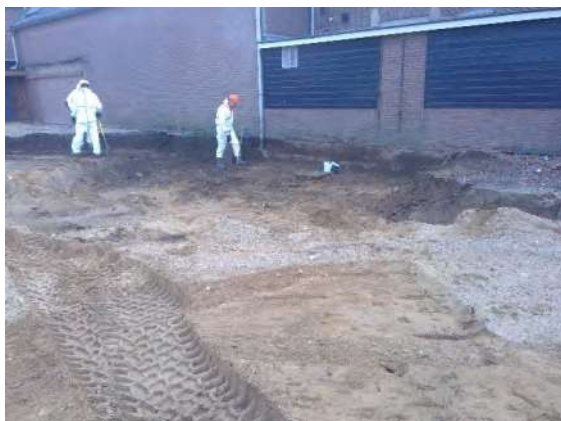
Foto 8 ontgraving met o.o. begeleiding
