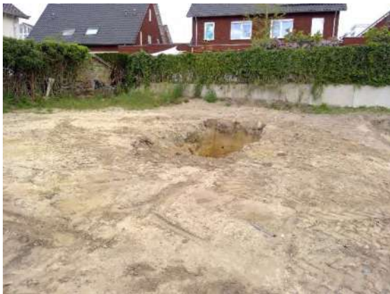
Foto 3 situatie tankgat na sanering
