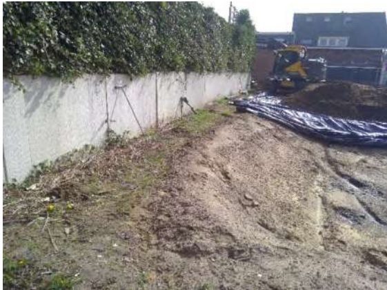
Foto 5 onderzoek langs keerwand ivm restverontreiging
