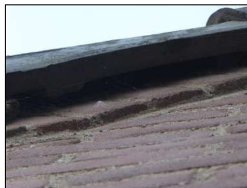
Noordseweg 2, ruimte achter dakpan.
