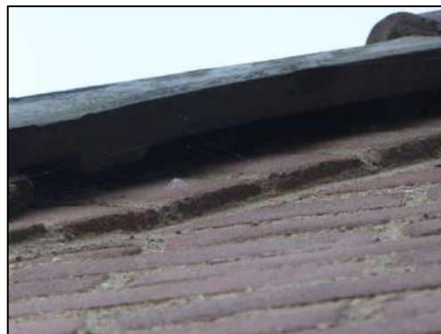
Noordseweg 2, ruimte achter dakpan.
