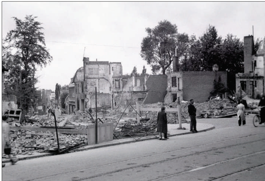
Afb. 2 - De zwaar beschadigde kruising van de Weverstraat en de Utrechtseweg. Bron: Gelders Archief, 1584-1096.
