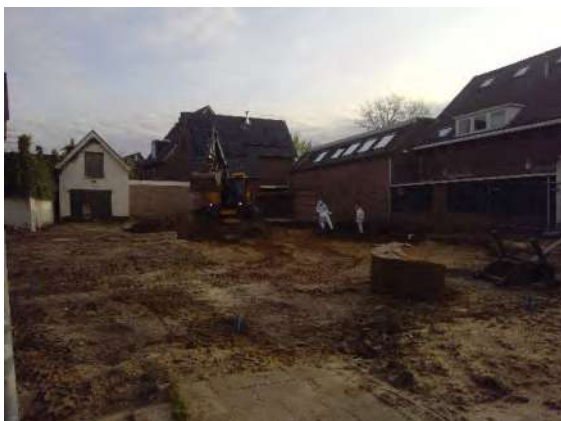
Foto 7 start ontgraving lood en zink verontreiging
