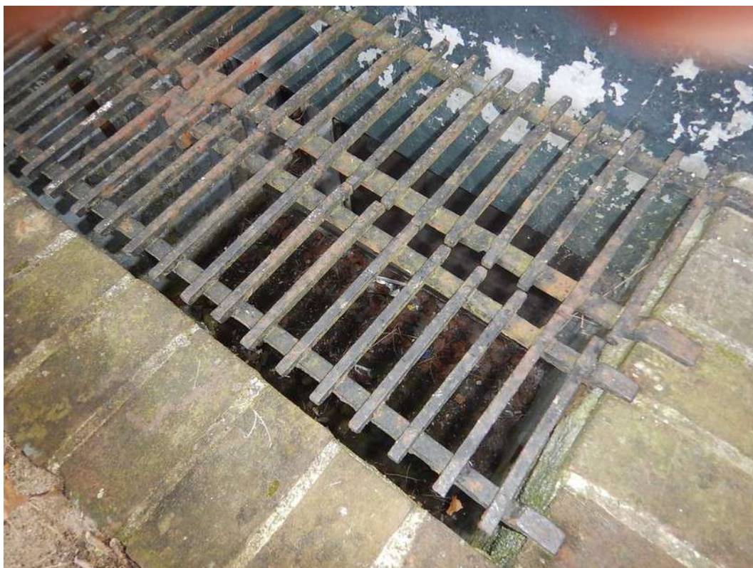
Figuur 8: Kelder onder woonhuis.
