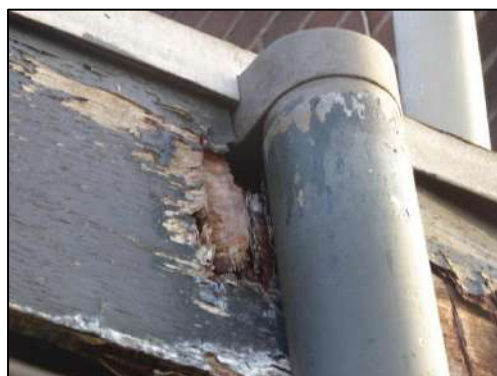
Utrechtseweg 79, ruimte achter betimmering.
