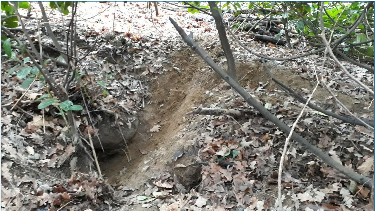
Figuur 5-3: westelijke pijp, eveneens als de zuidelijke pijp intensief belopen, pal onder een laurierstruik gelegen.
