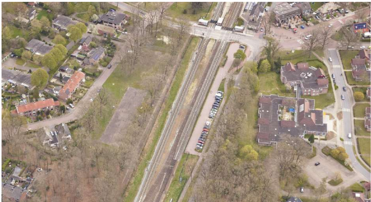
Afbeelding: luchtfoto plangebied 2021 (kijkrichting naar het oosten). Bovenaan het station Wolfheze en huidige spoorovergang van de Wolfhezerweg. Rechts langs het spoor de parallelweg en de huidige parkeerplaatsen. Helemaal rechts de gebouwen en het terrein van Pro Persona. (bron: Geo-obliek; Slagboom en Peeters)
