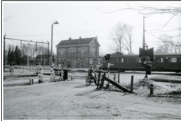
Afbeelding: spoorovergang en station Wolfheze in 1972 (kijkrichting naar het zuiden) met de toen net gebouwde voetgangerstunnel. (bron: Geldersch Archief)
