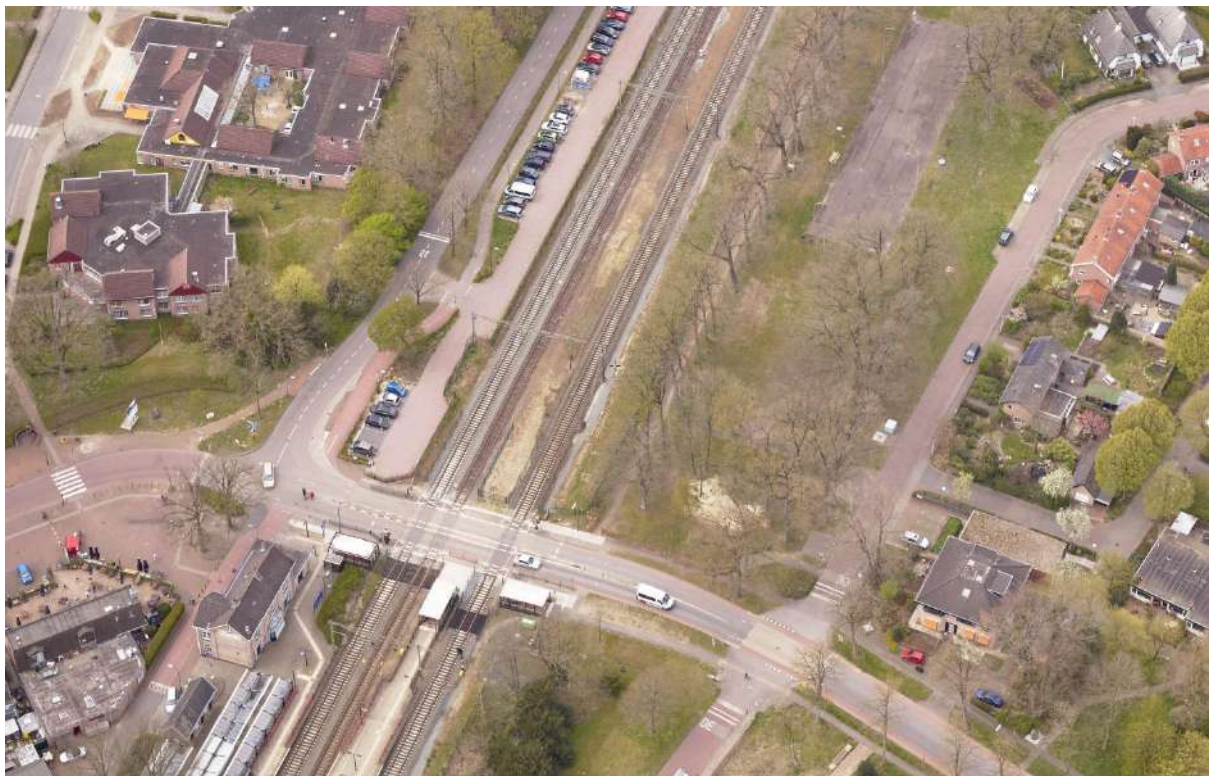
Afbeelding: luchtfoto plangebied 2021 (kijkrichting naar het westen). Onderaan het station Wolfheze en de huidige spoorovergang van de Wolfhezerweg. Links de parallelweg langs het spoor en rechts de Van Mesdagweg nabij het spoor (bron: Geo-obliek; Slagboom en Peeters)
