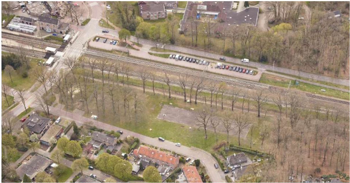
Afbeelding: luchtfoto plangebied 2021 (kijkrichting naar het zuiden). Links station Wolfheze en huidige spoorovergang van de Wolfhezerweg. Boven langs het spoor de huidige parkeerplaatsen en de Parallelweg. (bron: Geo-obliek; Slagboom en Peeters)
