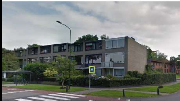
Bestaande woongebouwen langs de doorgaande weg
