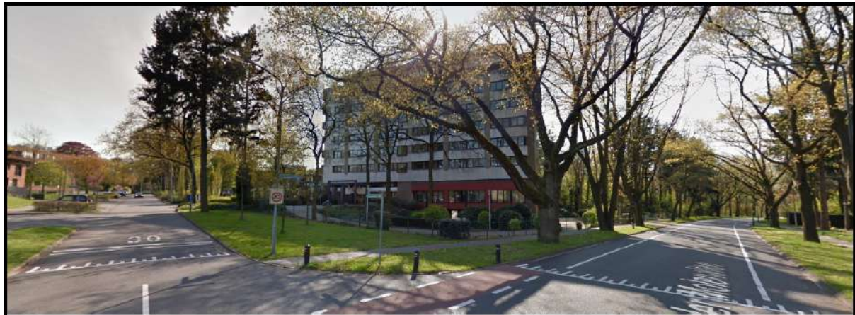
Bestaande leegstaande kantoorgebouw
