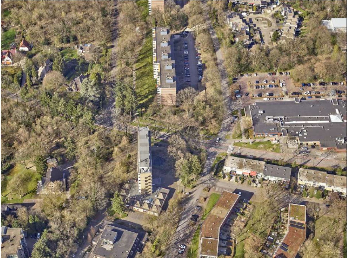
Afbeelding: luchtfoto 2021, bestaande gebouw en omgeving; kijkrichting naar het noorden (bron: GeoOblic, Slagboom en Peeters)
