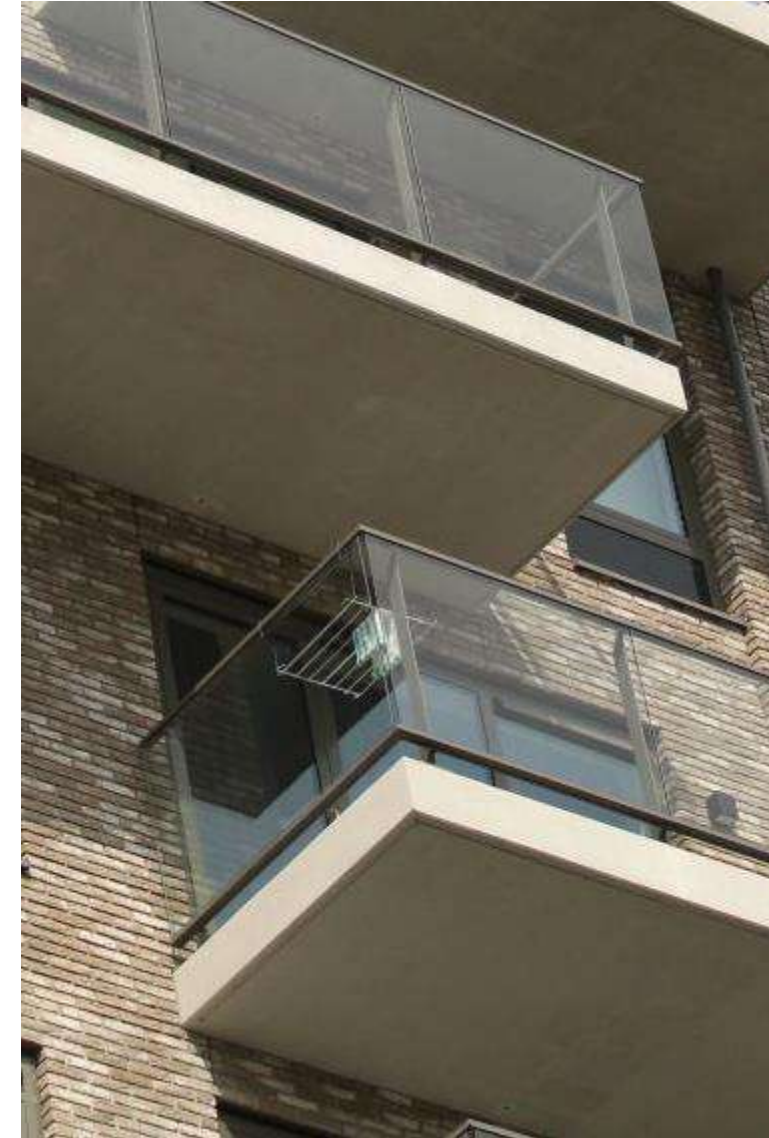
Prefab beton balkons, banden en dakrand
