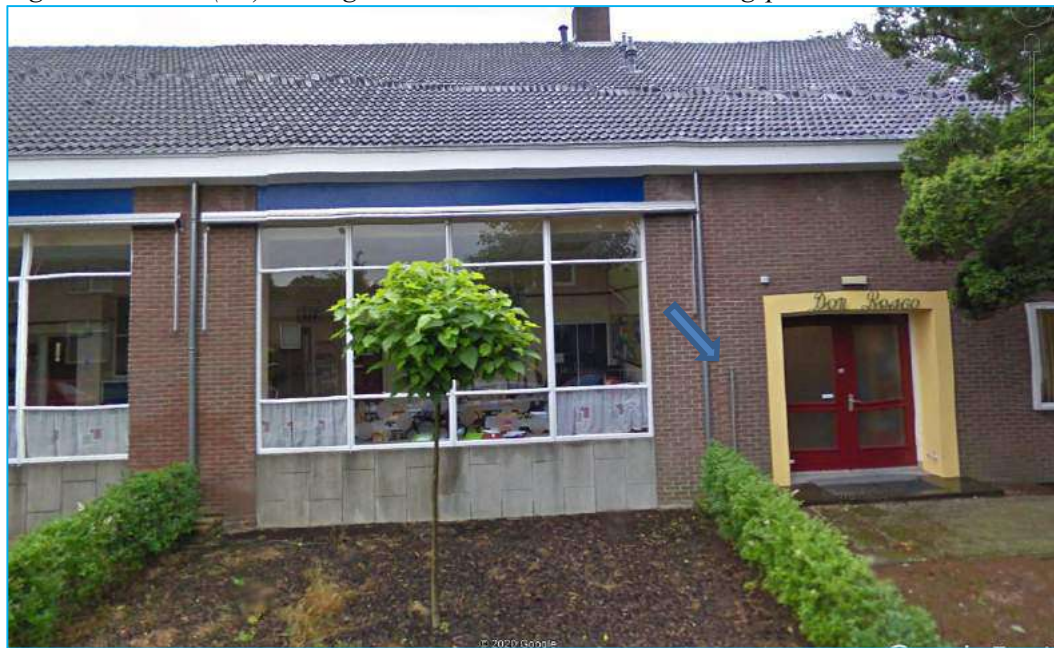
Figuur 1: locatie (vm)-ondergrondse HBO-tank met ontluuchtingspunt
