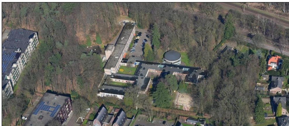
Luchtfoto 2019 plangebied, richting noorden (bron: GeoOblic, Slagboom en Peeters).
