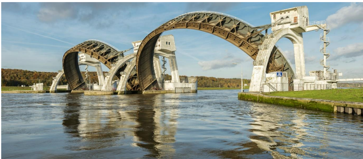
Foto 1: Het Stuwcomplex Driel gezien vanuit westelijke richting
