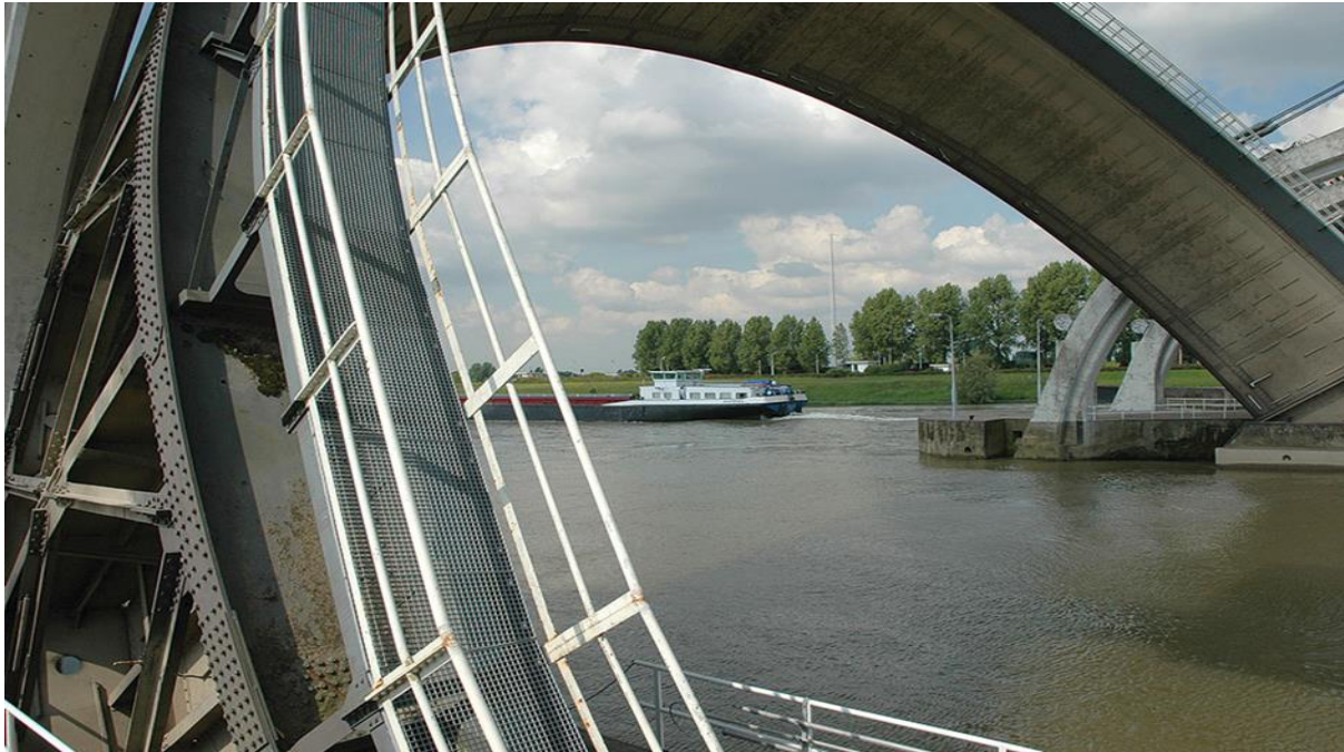
Foto 2: Doorkijk door de geopende vizerschuif aan de zuidkant van Stuwcomplex
