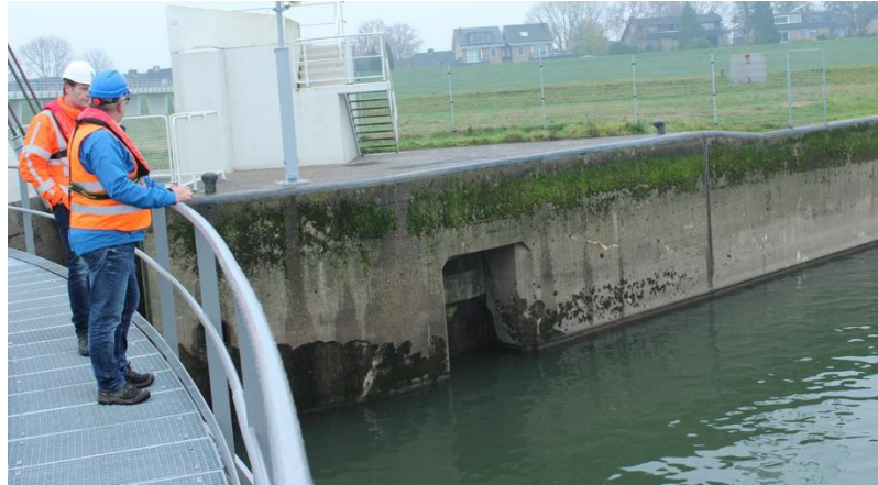
Foto 3: Uitstroomopening “visluis” in zuidelijke pijler
