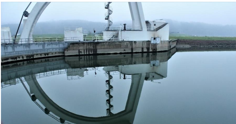
Foto 4a: inlaat van de vissluis (noordpijler)
