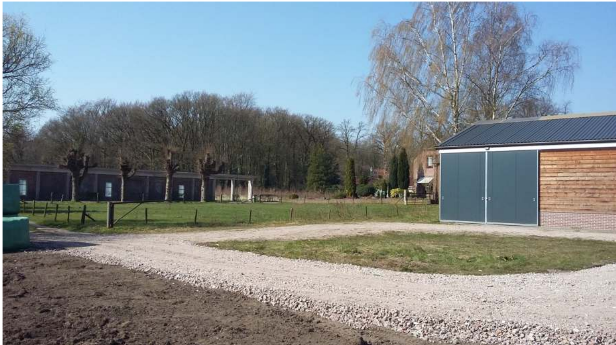
Afbeelding 13: Recente (voorjaar 2020) foto van de planlocatie met rechts de nieuwe schuur en op de achtergrond de Hartenseweg met de historische muur aan de andere zijde van de weg. In de huidige situatie ligt er meer (puin-)verharding dan op de luchtfoto's zichtbaar is. Het weiland voorbij de erfafscheiding met palen hoort niet bij de bestemmingsplanwijziging.
